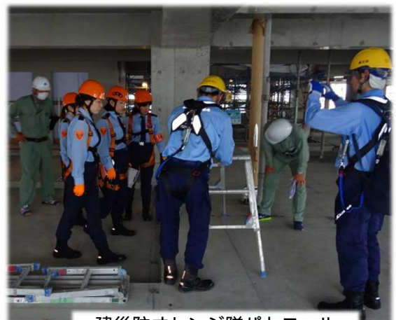
建災防オレンジ隊パトロール
